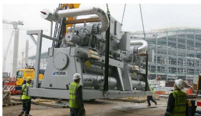
Figures 5-6. One of four packaged ammonia chillers of 6.6 MW each being installed at Heathrow Airport's Terminal 5 L'un des quatre refroidisseurs à ammoniac de 6,6 MW en voie d'installation au Terminal 5 de l'aéroport de Heathrow
